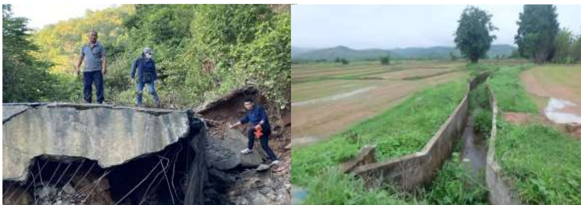
ภาพที่ 7 สภาพอ่างเก็บน้ำที่ชำรุดและระบบชลประทาน
